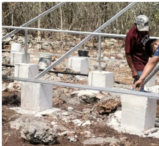
Ilustración 5 - Bases de cemento listas
