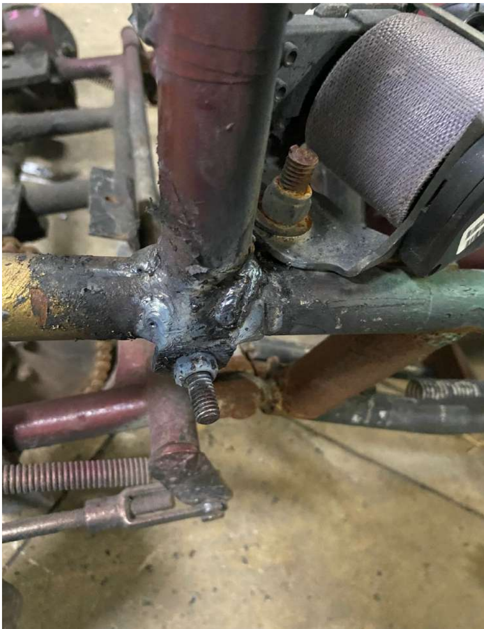
Figura 26.- Soldadura estructural del chasis.
