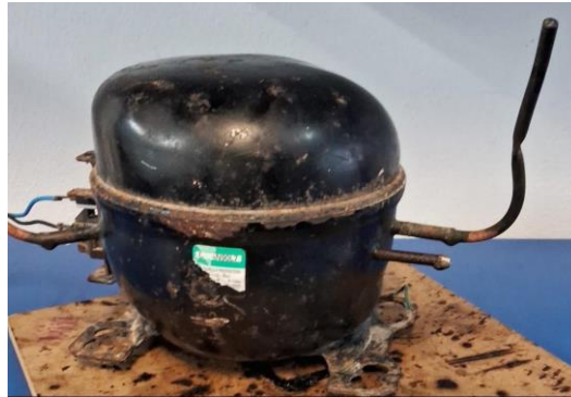
Imagen 2. Se observa que presenta zonas de oxidación, así como el hecho que presenta decoloración.
