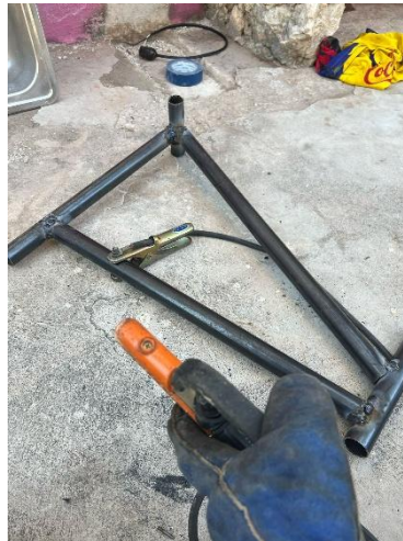
Ilustración 67. Proceso de soldado.
