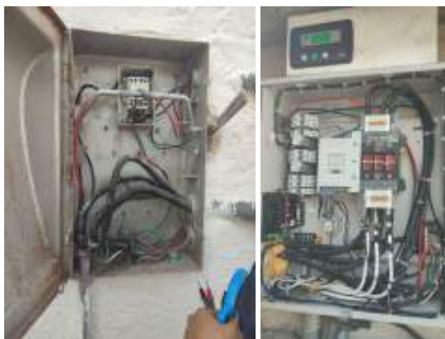
Figura 16 y 17. Contactor del inversor y tablero de transferencia
