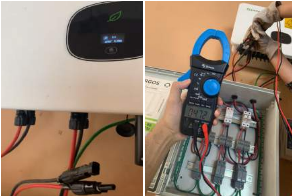
Figura 26 Y 27. Detección de conexión en MPPT 4 y valores normales de MPPT 2
