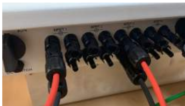
Figura 25. Distribución MPPT inversor Growatt trifásico
