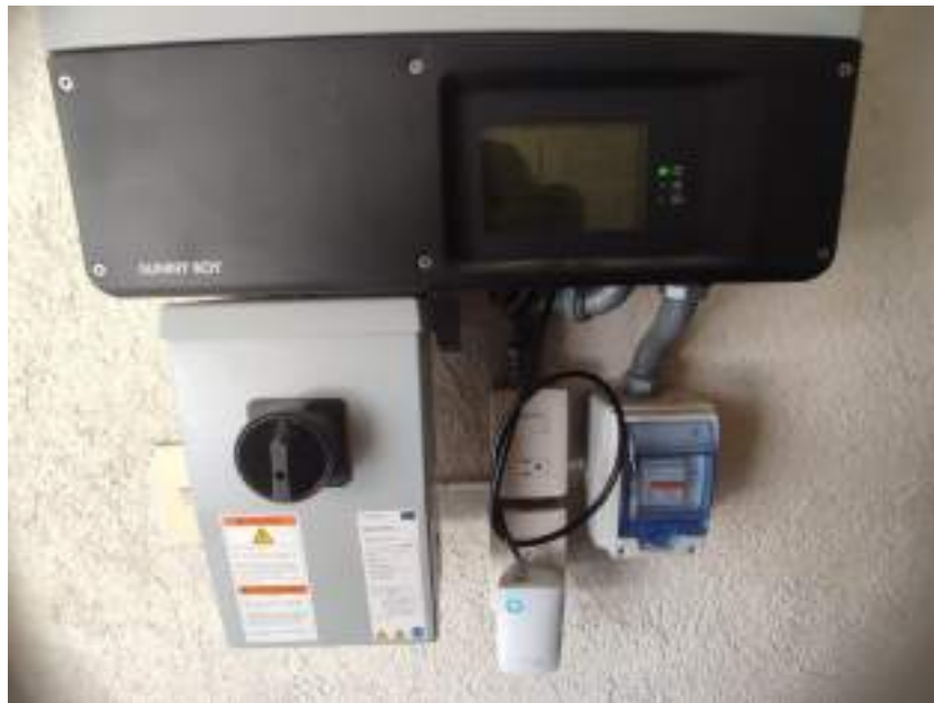
Figura 22. Inversor SMA funcionando de manera óptima
