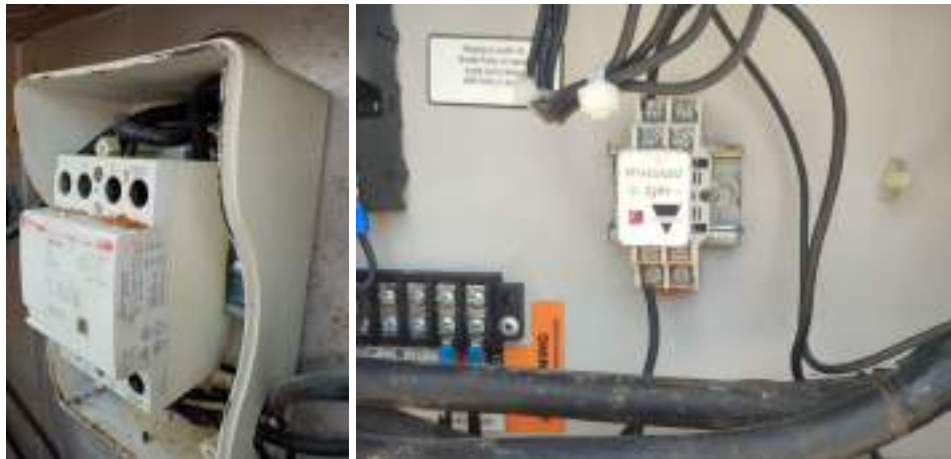
Figura 18 y 19. Contactor y relé antes del correctivo
